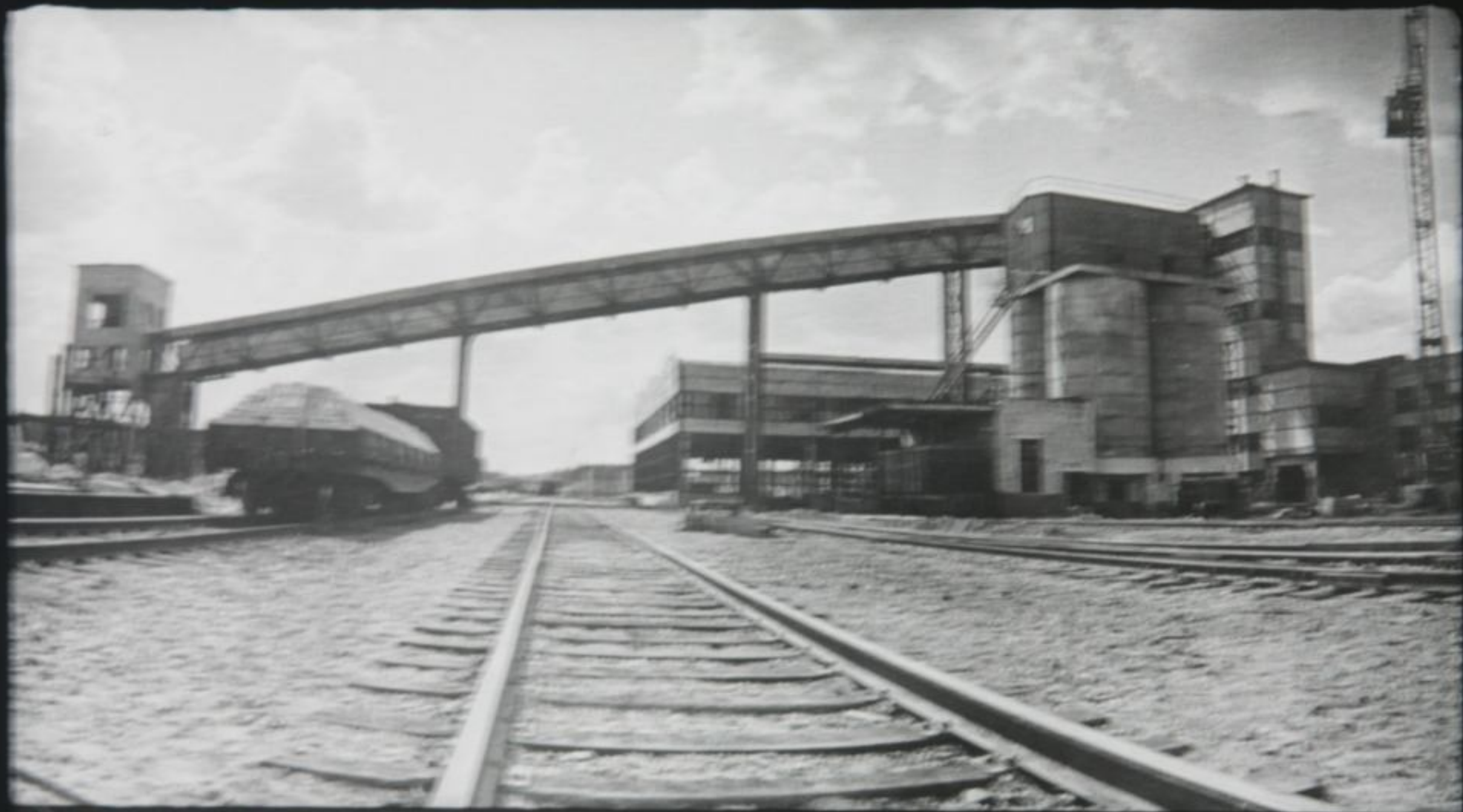
Летом 1975 г. вступила в строй 1-я очередь завода железобетонных изделий.
