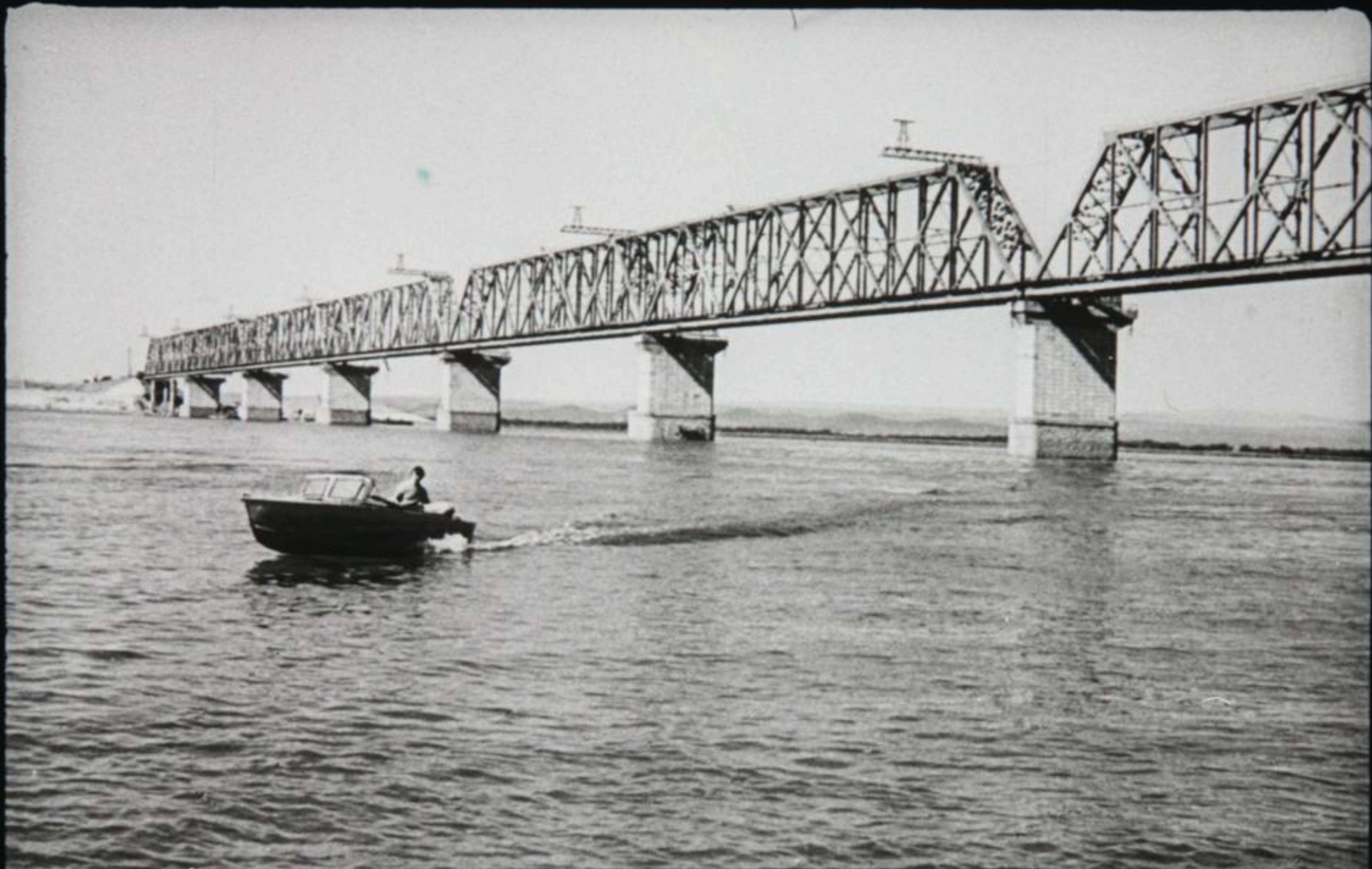
к «восточным воротам» БАМа. Так называют новый полтора-километровый мост через Амур—самый большой на всей магистрали.
